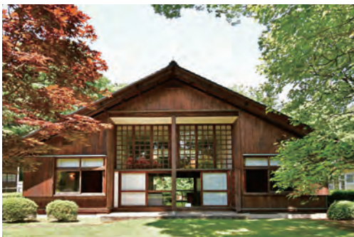
五寸勾配の大屋根が建物全体を覆い、壁は縦に長い板を並べた「縦板張り」を用いている
