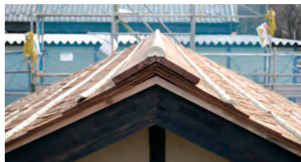
屋根を横から見ると杉板の重なりがよくわかる(工事中)
