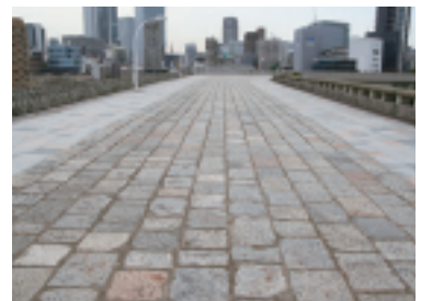
プロムナードの石畳はかつての都電の敷石。両端は車いすが通行できるようフラットに改修
