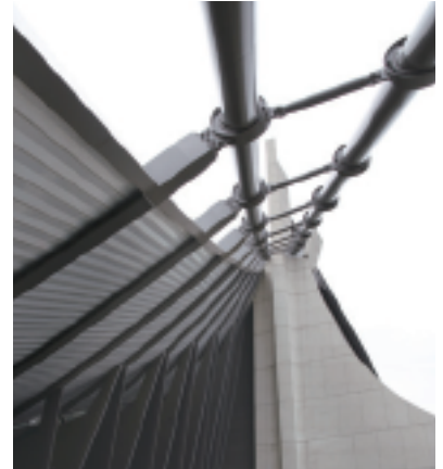
気温や湿度による屋根材の伸縮でギシギシと音が鳴り、建物が生きているような感覚を覚える
