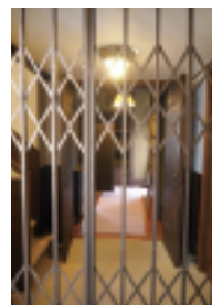
1・2階に設置された防犯シャッター
